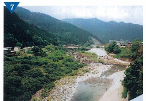
▲滝つ河内整備(完了)
