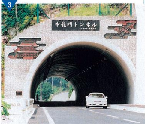
▲中龍門トンネルの整備(完了)
