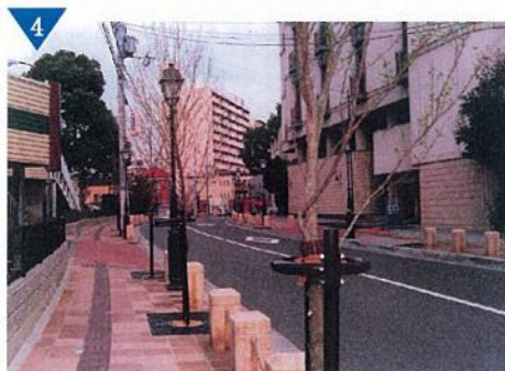
▲都市計画道路宝塚駅南口線整備(完了)
