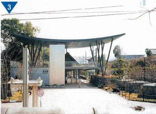
▲ 京阪坂本駅前広場整備及び駅舎修景(完了)
