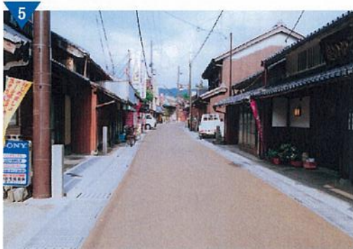
▲「土山宿」での街並み整備（進行中）
