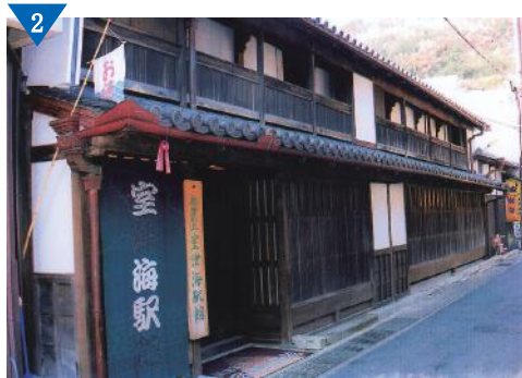
▲室津海駅館の整備（完了）
