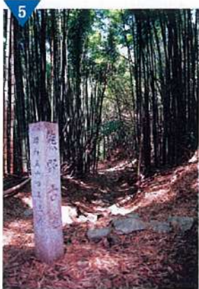
▲熊野古道敷石修景整備(進行中)
