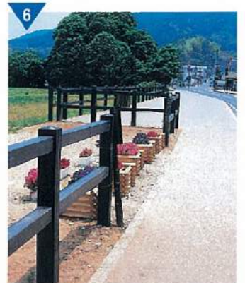
▲風土を活かした歩道整備(完了)
